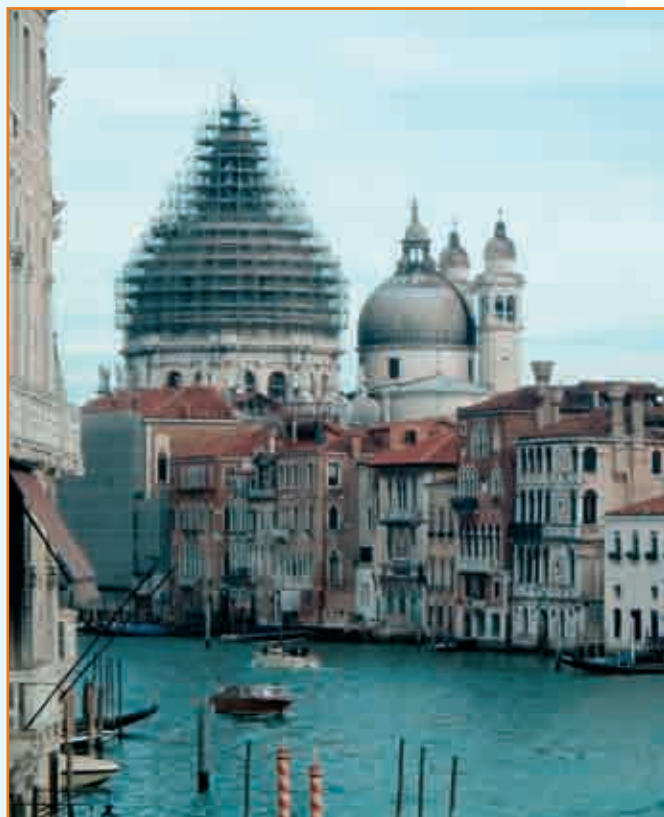
Fig. 9.2 • Il grave problema del graduale affondamento di Venezia è causato dall'innalzamento del livello del mare (eustatismo) e dall'abbassamento del suolo (subsidenza), ma è anche intensificato dai fattori antropici.
