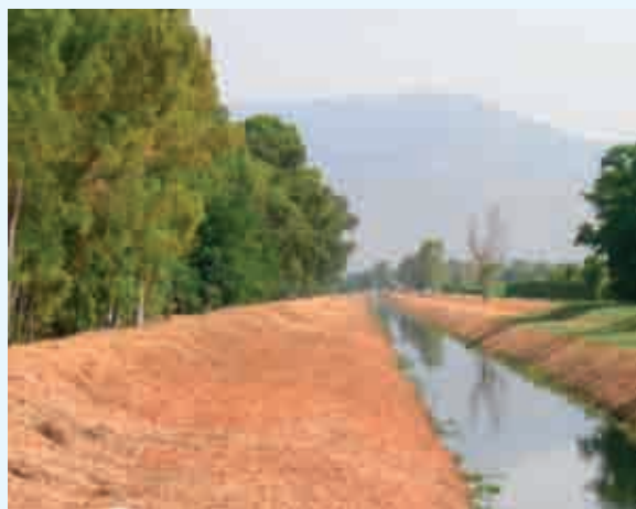
Fig. 2.6 ● Le opere di bonifica effettuate all'inizio del secolo scorso erano finalizzate a creare reti idrauliche per la regimazione delle acque stagnanti nelle zone da destinare all'agricoltura.
